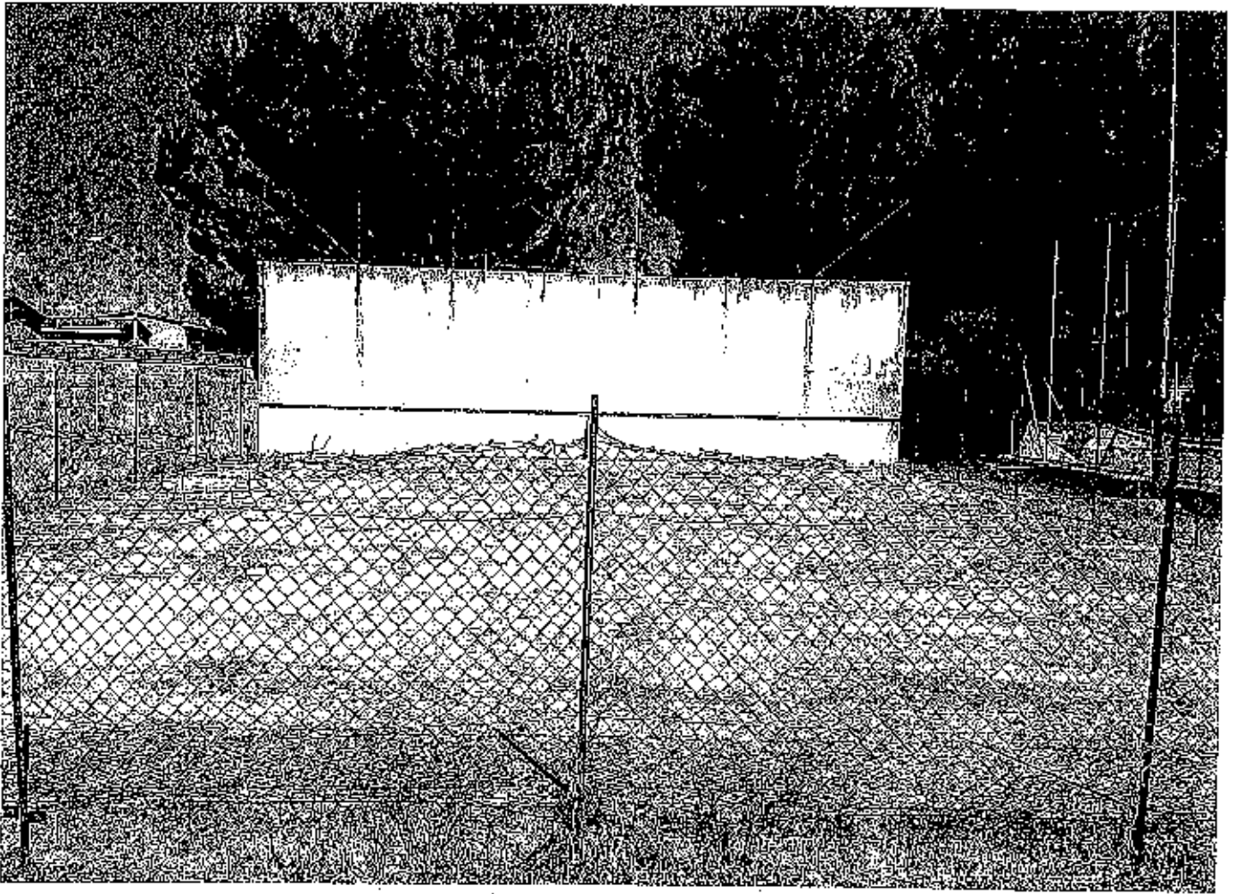
FOTO N° 5 MURO DI ALLENAMENTO
